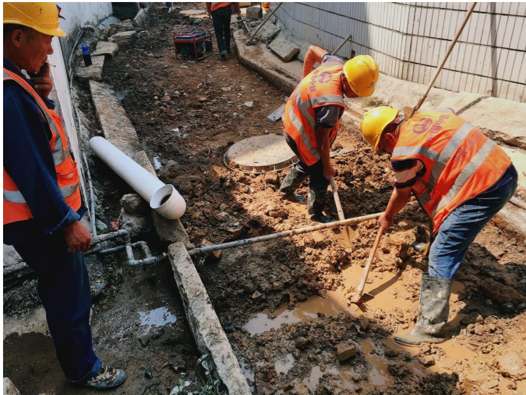
工人敷设截污管道
