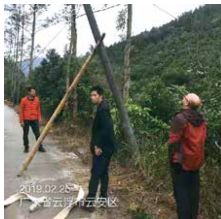
路边倒伏的电线杆得到了尽快的维修
