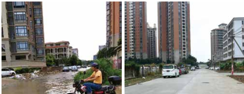
道路积水严重区域改造前后对比图
