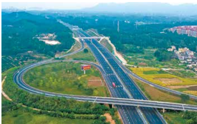
沈海高速水口至白沙段改扩建工程于2020年底顺利通过竣工验收
